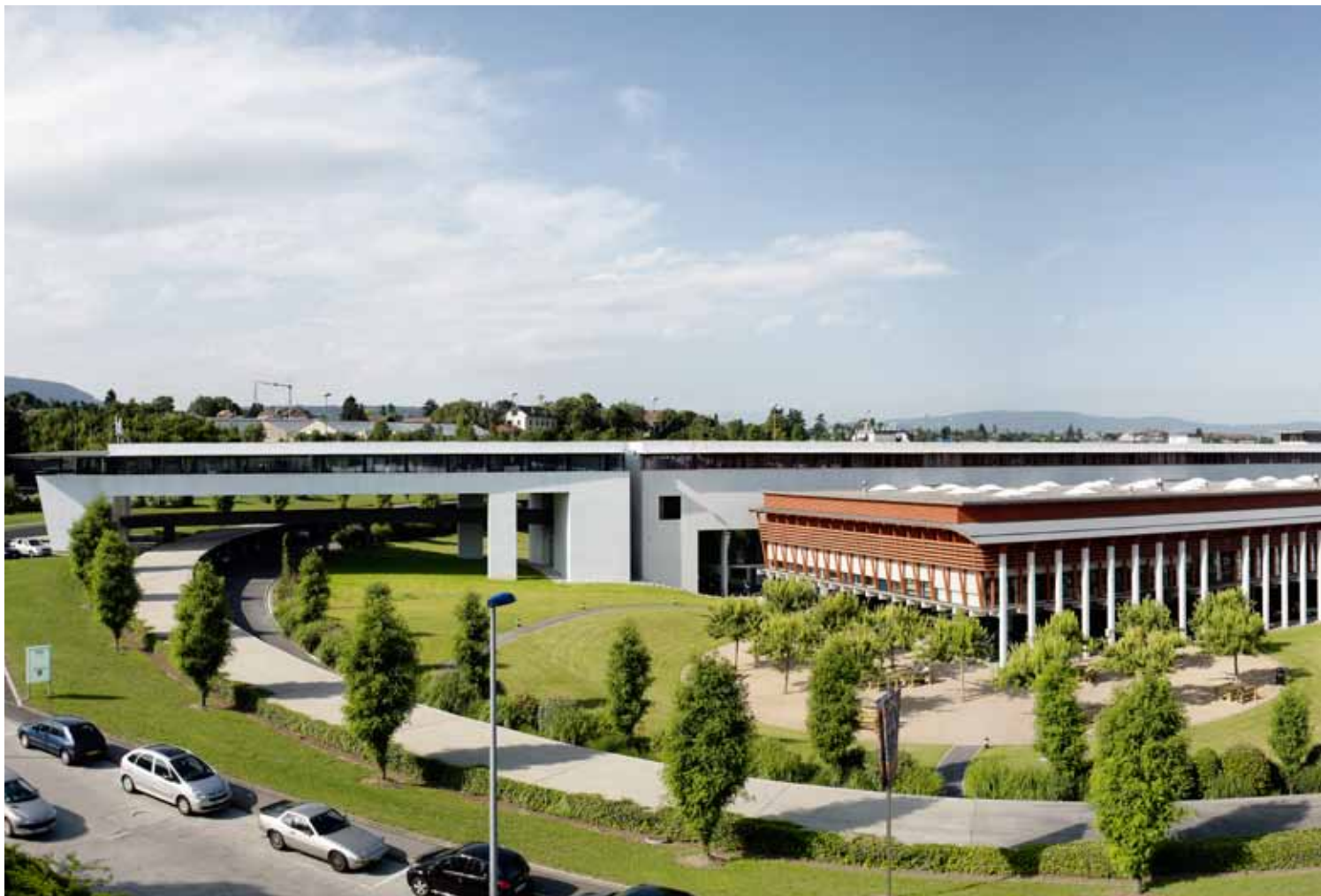
Sopra, i nuovi stabilimenti e uffici a Plan-les-Ouates, Ginevra. Above, the new factories and offices in Plan-les-Ouates, Geneva.
